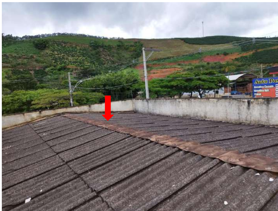
Figura 09 – Destaque para o telhado do plenário com as telhas e rufos em estágio final de utilização, causando patologias a edificação.
