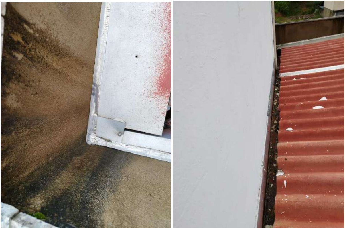
Figura 24 e 25 – Destaque para o rufo do telhado do pavimento superior soltando da parede, amassado nas emendas e calhas com ausência de inclinação.
