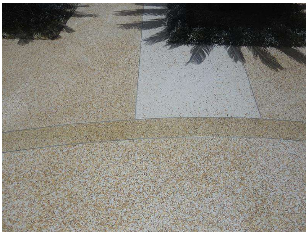
Figura 02 - revestimento em textura marmorizada
