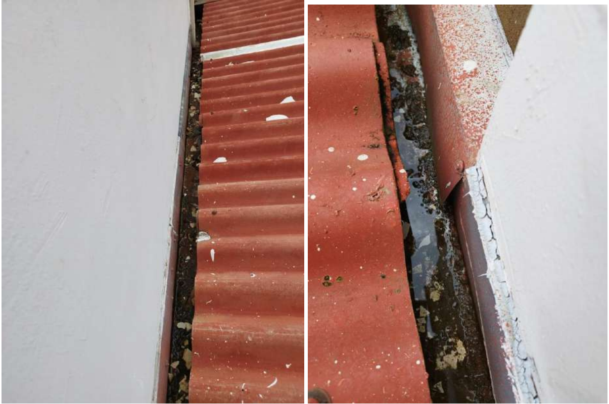
Figura 24 e 25 – Destaque para o rufo do telhado do pavimento superior soltando da parede, amassado nas emendas e calhas com ausência de inclinação.
